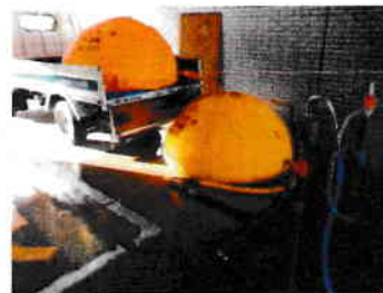
運搬給水の実施
